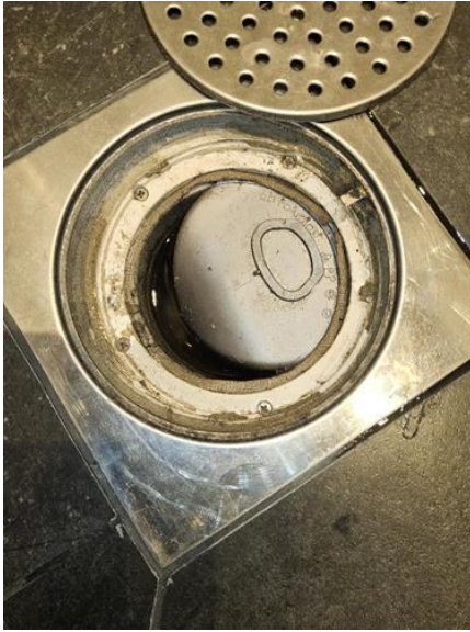
Våtrom - [Sluk bad]
