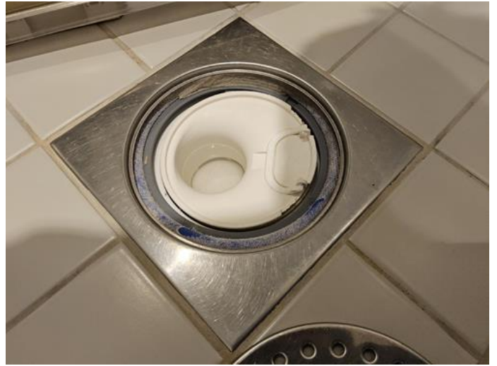
Våtrom - [Sluk på bad (dusjsonen).]
