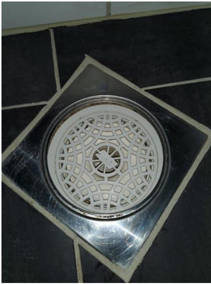
Våtrom - [Sluk på bad]
