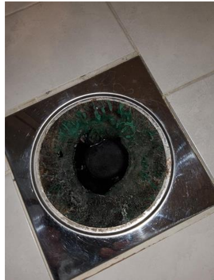
Våtrom - [Sluk på bad i 2. etg.]
