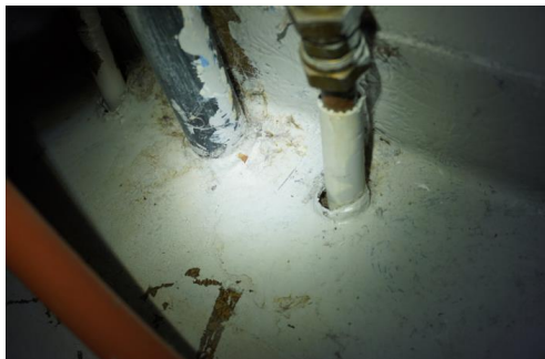
Utett gjennomføring i gulv (våtsone)
