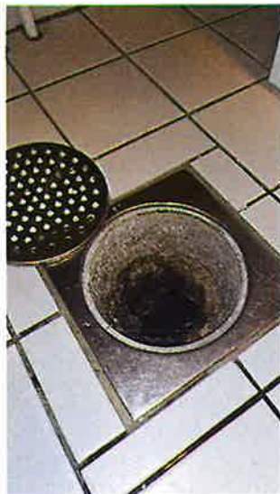
Våtrom - [Sluk vaskerom]
