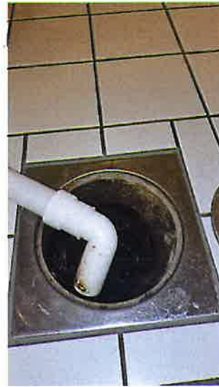
Våtrom - [Sluk bad]
