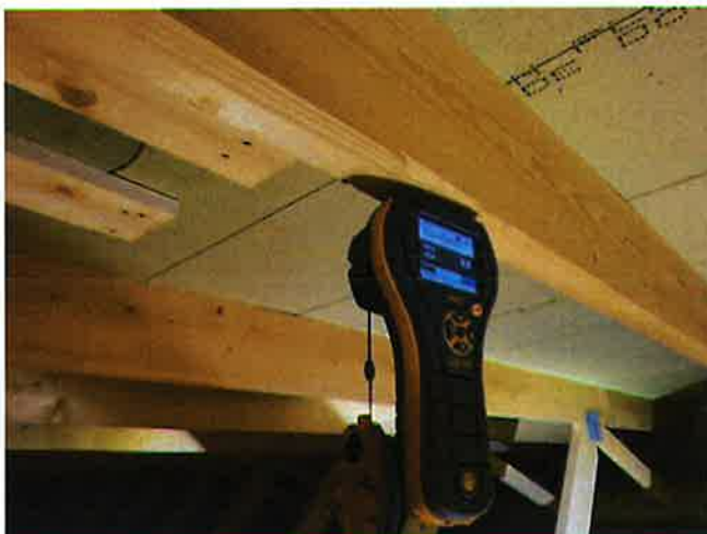
Konstruksjonsoppbygging - [Måling i treverk med pigg, kaldloft]
