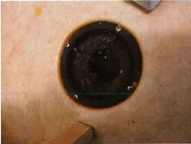
Våtrom - [Sluk vaskerom]
