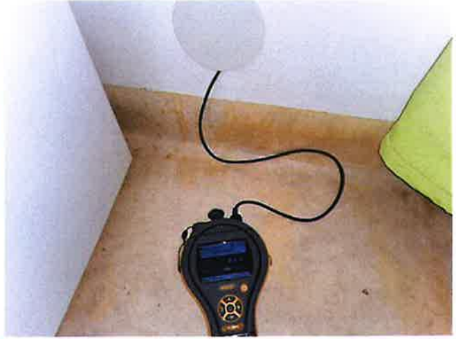
Våttrom - [Hulltaking/fukmåling tilstøtende vegg bad, fra vaskerom ]
