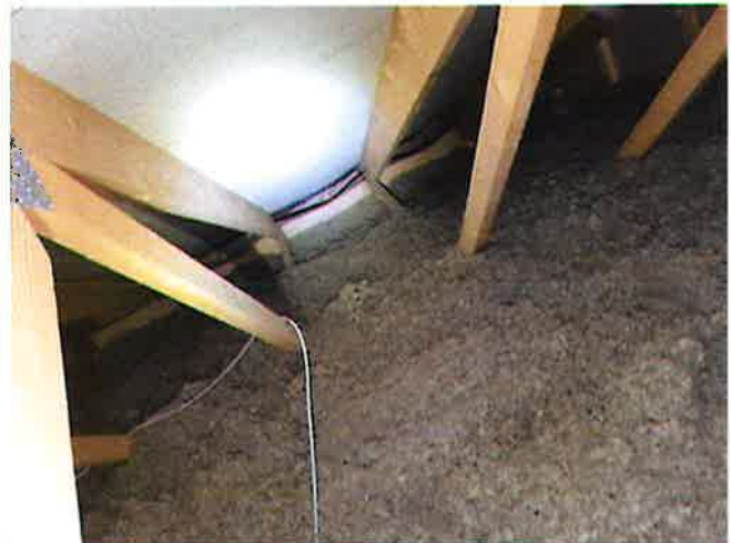
Konstruksjonsoppbygging - [Fuktmerker taktro registrert ca. over kjøkken, kaldloft]
