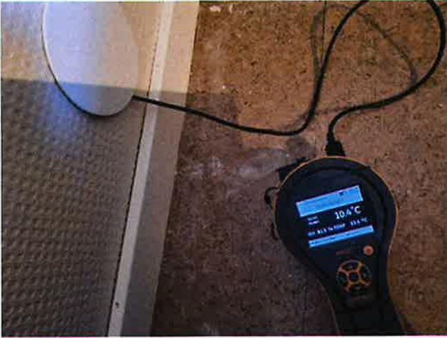
Konstruksjoner (tilfarergulv, himling og vegger). - [Hulltaking/fuktmåling rom under terreng]
