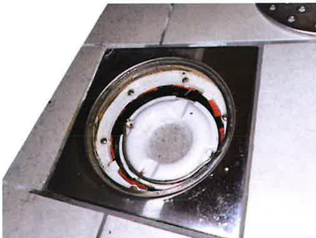
Membran, tettesjikt og overgang til sluk. - [Hovedsluk bad ]
