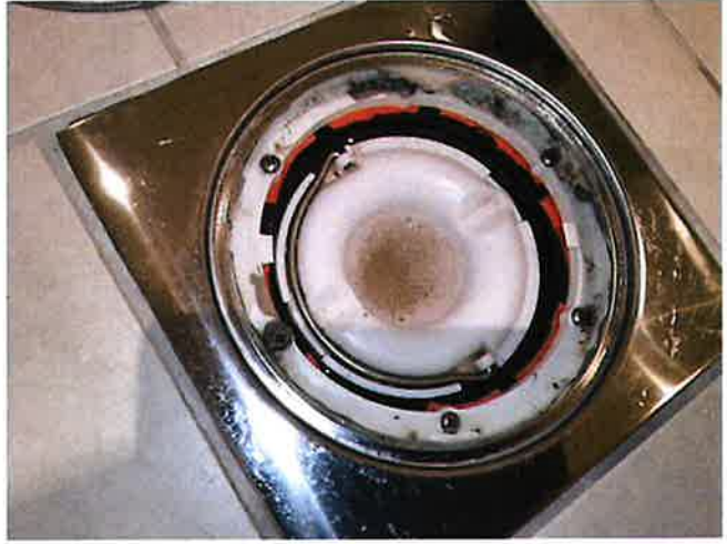
Membran, tettesjikt og overgang til sluk. - [Hjelpesluk bad ]
