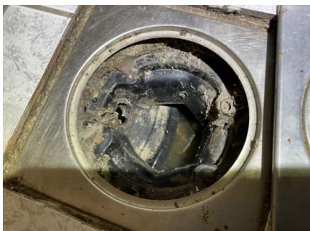
Sluk av plast mangler stakeplugg og membranmansjett
