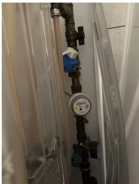
Vannmåler og fordelerskap plassert på bad i 1. etasje.
