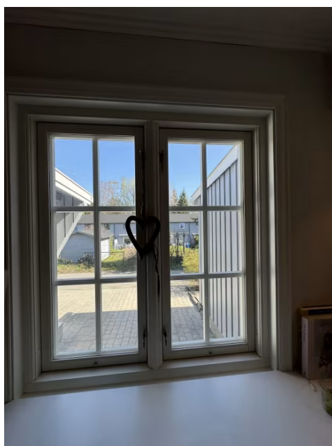
Vindu på kjøkken fra 2017.
