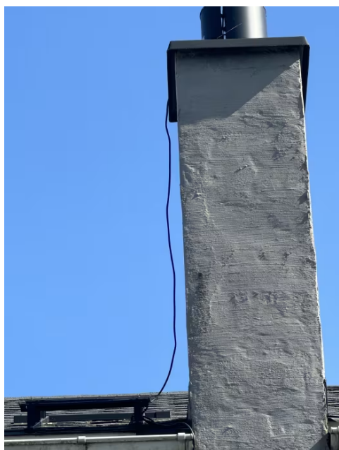
Vifte er montert for bedre opptrekk i pipe. Takstige for feier er montert ved pipe.
