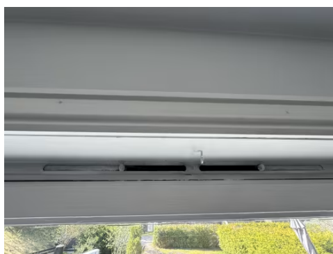
Eldre vinduer i stue har lufteluker over glass.
