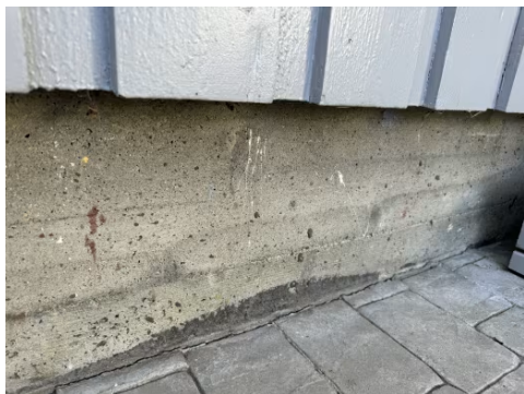
Grunnmur i betong.
