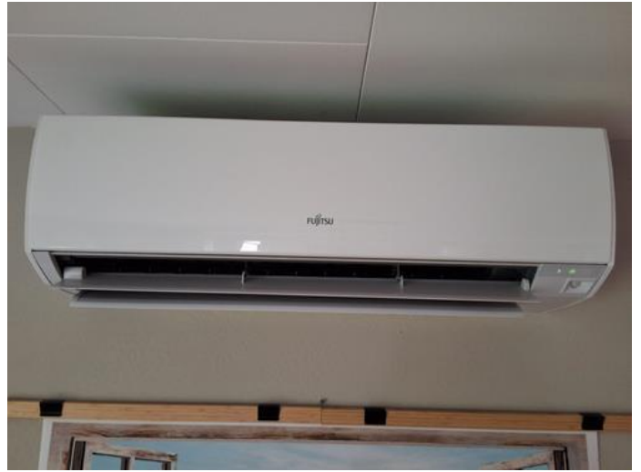
Tekniske anlegg, VVS anlegg (Sjekkpunkter utover det som er inkludert i andre rom) - [Varmepumpe i stuen]
