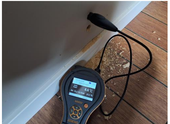
Våtrom - [Fuktmåling bad 1.etg]
