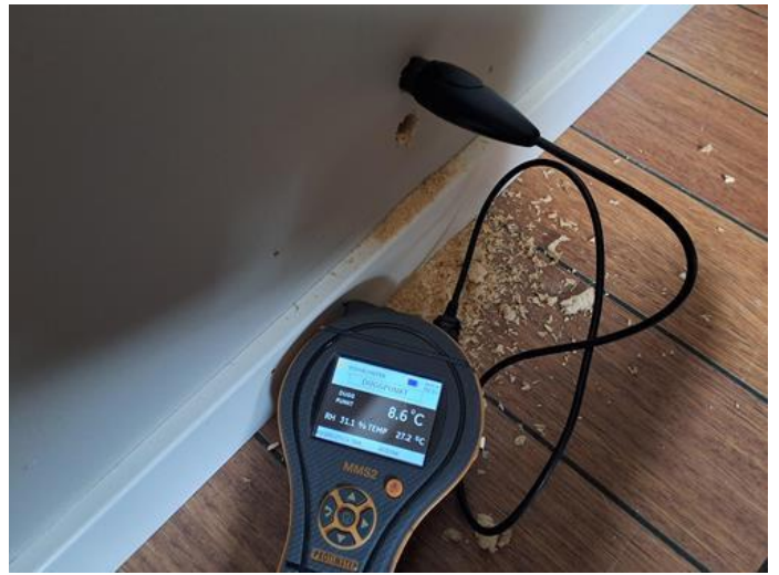
Våtrom - [Fuktmåling bad 1.etg]
