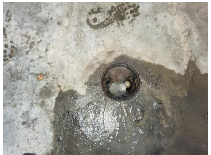
Tekniske anlegg, VVS anlegg (Sjekkpunkter utover det som er inkludert i andre rom) - [Sluk kjelleren ]
