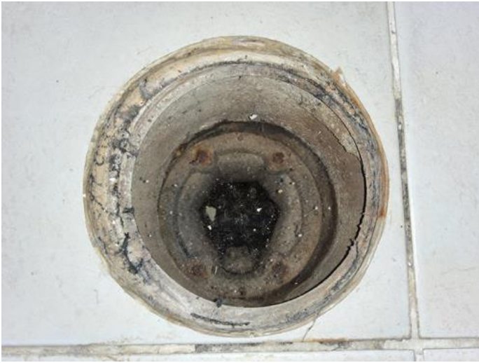
Våtrom - [Sluk på vaskerom/teknisk rom ]
