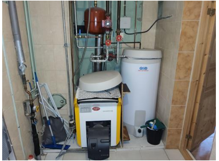
Tekniske anlegg, VVS anlegg (Sjekkpunkter utover det som er inkludert i andre rom) - [Fyringsanlegg, varmtvannsbereider og stoppekran ]
