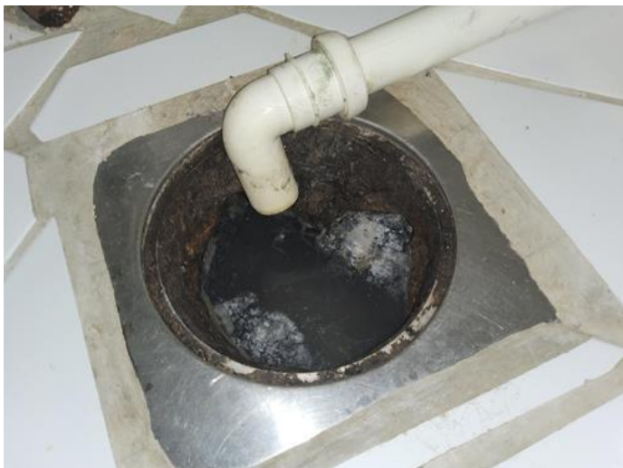
Membran, tettesjikt og overgang til sluk. - [Sluk bad 1]
