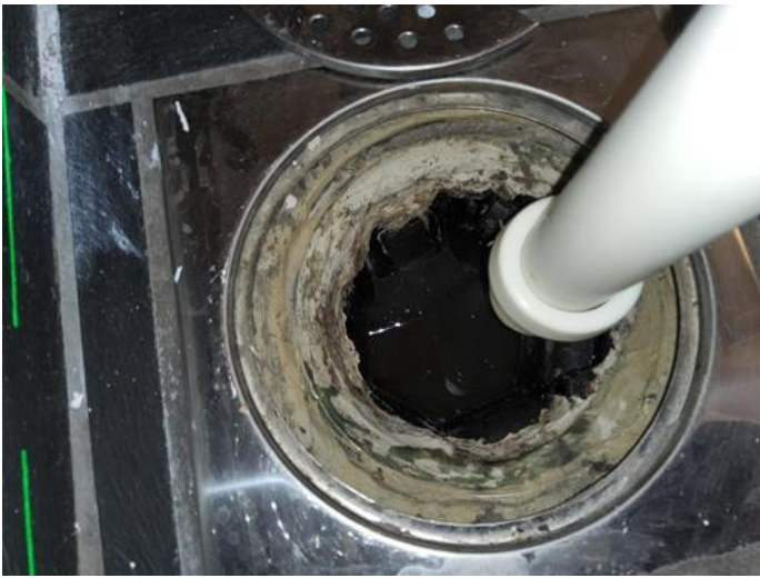
Membran, tettesjikt og overgang til sluk. - [Sluk vaskerom ]
