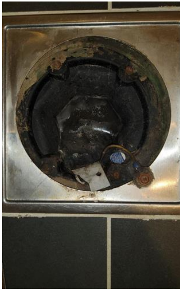
Membran, tettesjikt og overgang til sluk. - [Sluk bad underetasje 1]
