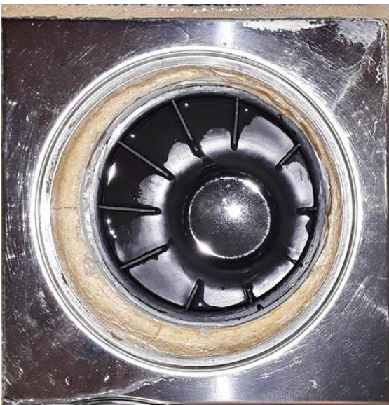
Våtrom - [Sluk bad underetasje]
