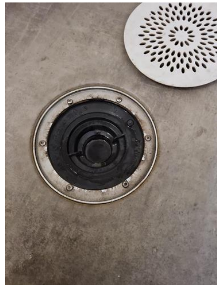
Våtrom - [Sluk bad u.etg (utleiedel)]
