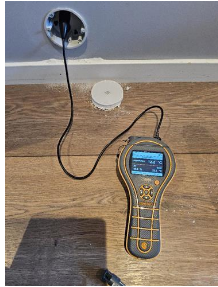
Våtrom - [Fuktmåling tilstøtende rom til bad 1.etg ]
