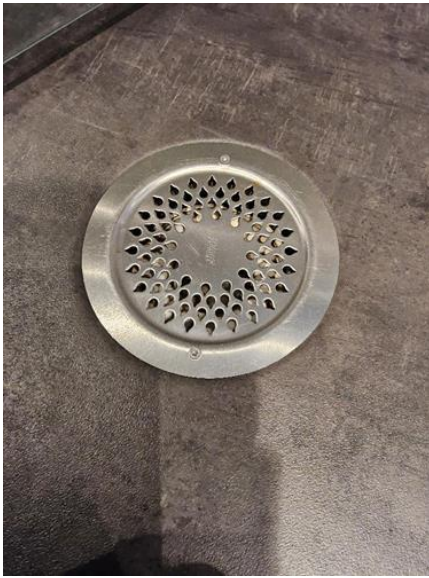
Våtrom - [Sluk bad 1.etg ]
