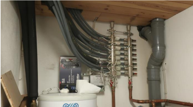
Her er rørene som går opp i gulvet i andre etasje.
