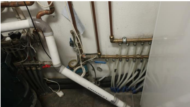
Til venstre i bilde ser en rørene som går til gulv ene i første etasje.
