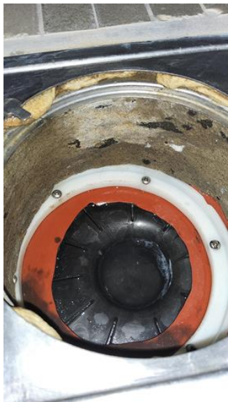
Våtrom - [Sluk bad]
