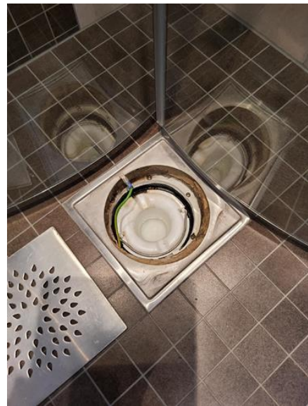
Membran, tettesjikt og overgang til sluk. - [Sluk Baderom 1.etasje. ]
