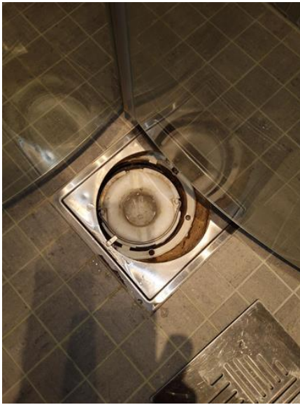
Membran, tettesjikt og overgang til sluk. - [Sluk Baderom U.etasje. ]
