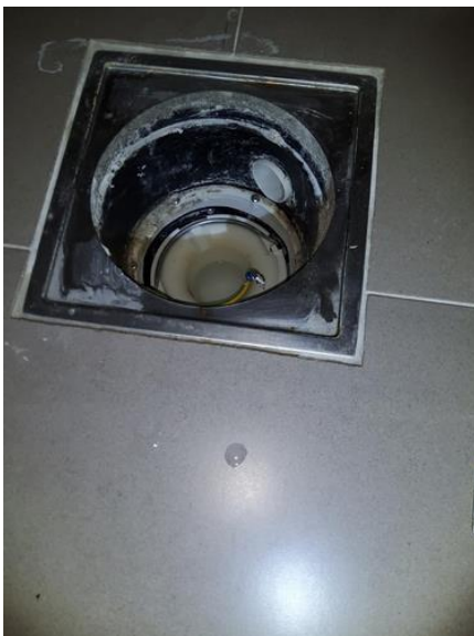
Membran, tettesjikt og overgang til sluk. - [Hovedsluk Baderom 2.etasje, under innredning.]
