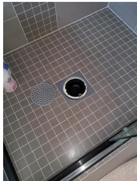
Membran, tettesjikt og overgang til sluk. - [Hjelpesluk Baderom 2.etasje, i dusjhjørne. ]
