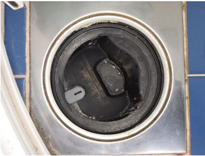
Membran, tettesjikt og overgang til sluk. - [Sluk på baderom i 1.etasje]
