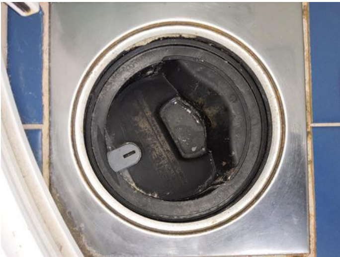
Membran, tettesjikt og overgang til sluk. - [Sluk på baderom i 1.etasje]
