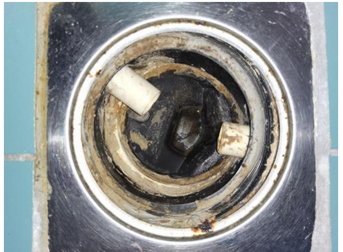
Membran, tettesjikt og overgang til sluk. - [Sluk på baderom i 2.etasje]
