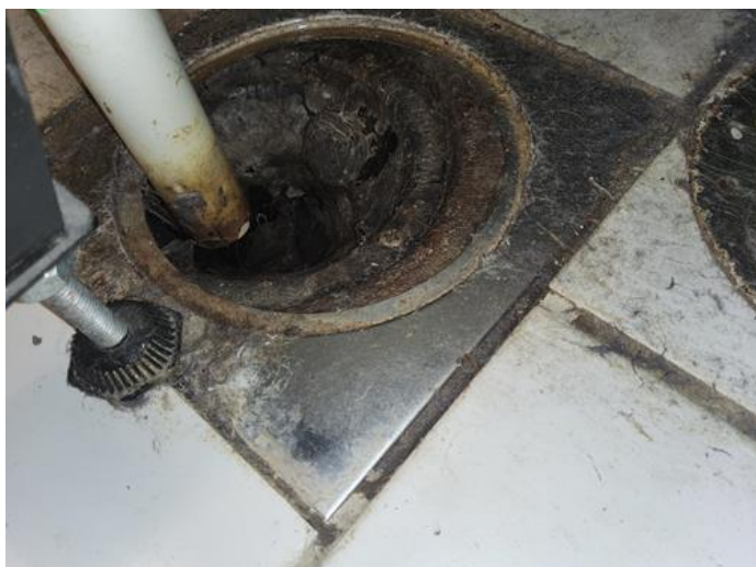
Membran, tettesjikt og overgang til sluk. - [Sluk bad fra entré]
