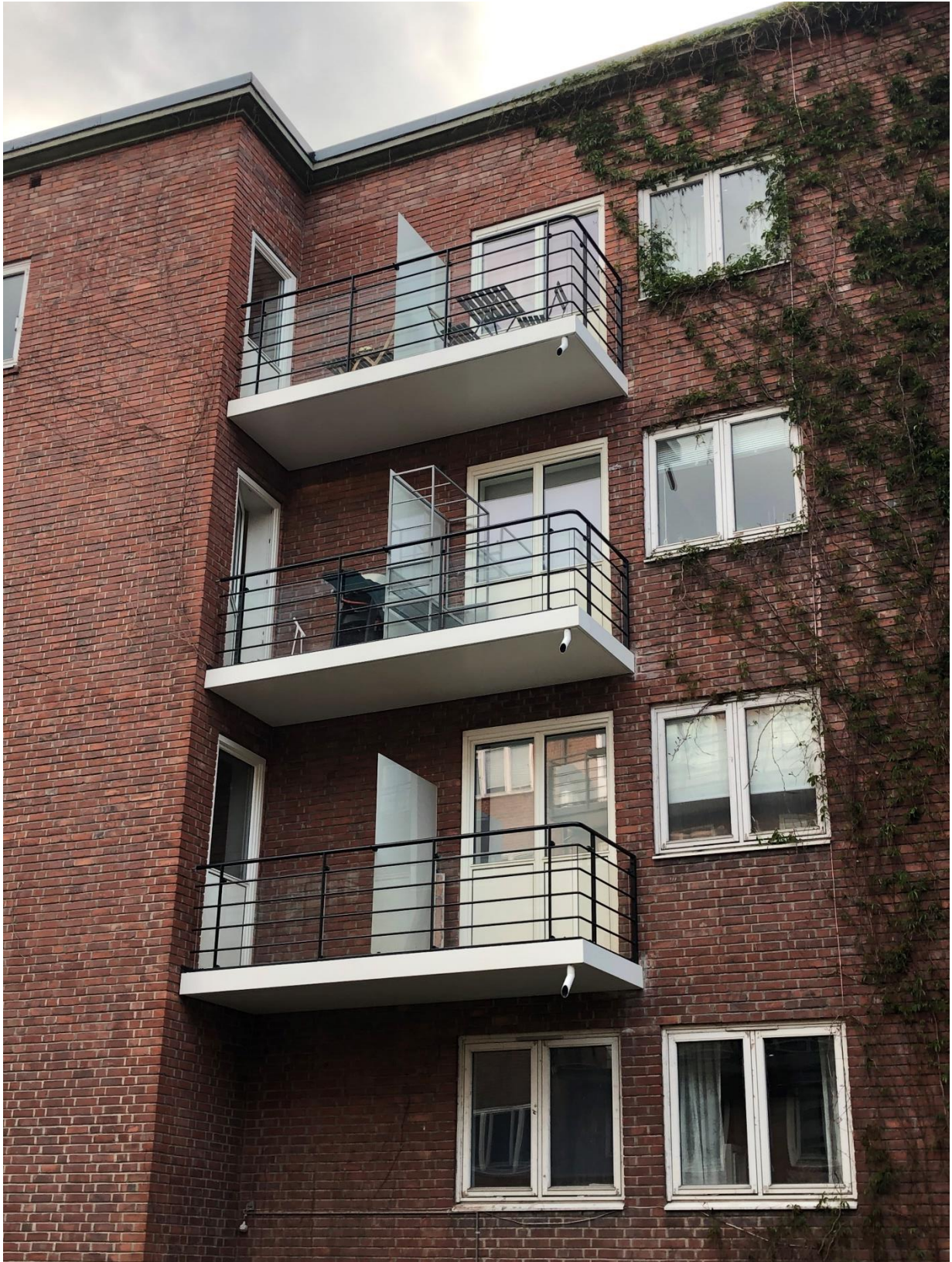
Fagerborggata 54 Oslo. Her ønsket kommunen et utrykk i betong. Vi ordnet det, men av andre materialer pga. vekt.
