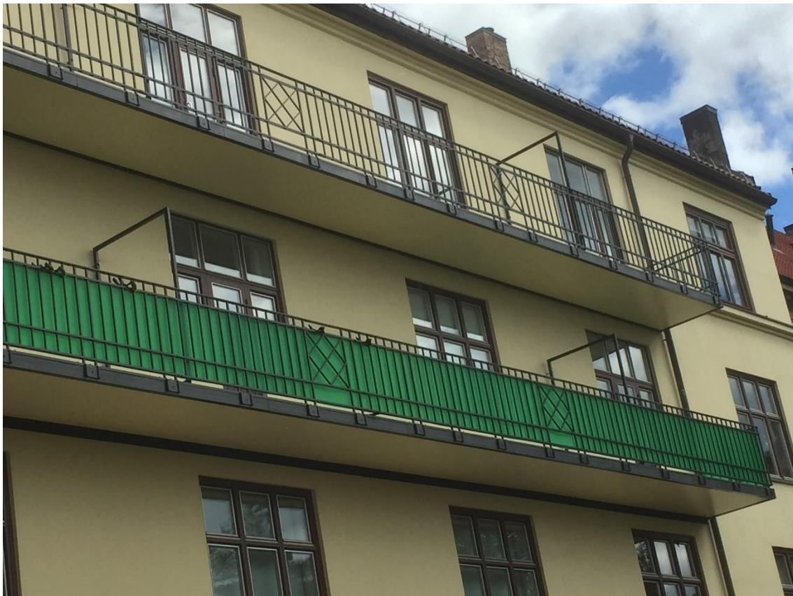
Jørgen Løvlands gate 25 Oslo. Nye brannbalkonger. Rekkverk utført som originalutførelse da dette var et krav.
