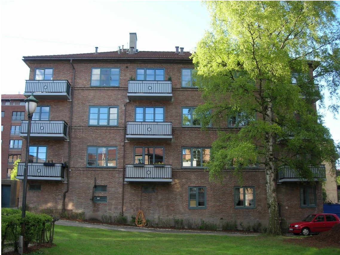
Løvenskioldsgate 22 Oslo. Rekkverk med plater på innsiden.
