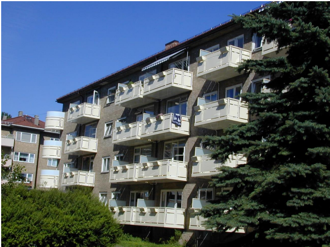
Tøyen Bygg II Oslo. Nye balkonger med rekkverk av stål utført i originalutførelse. Sideskjermer i frostet glass.
