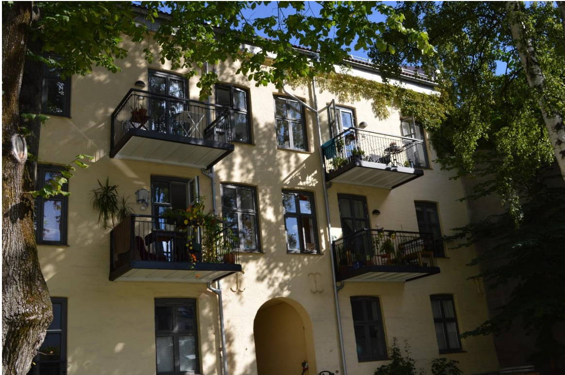
Thorvald Meyers gate 85. Vårt standard rekkeverk type 1900.
