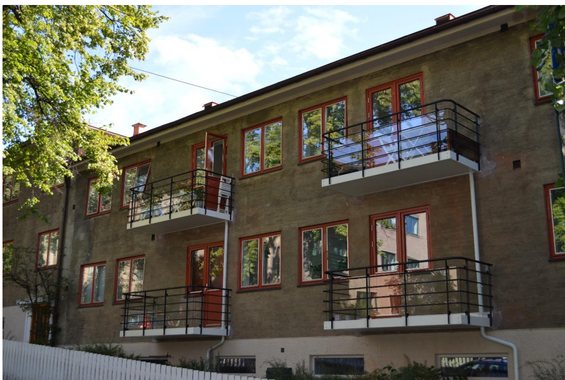
Vallegata 9 Oslo. Glassrekkverk med horisontale rør i stål. Her ønsket kunden en hvit balkongramme.
