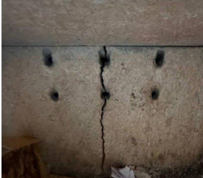
Sprekk i stein i brennkammeret.
