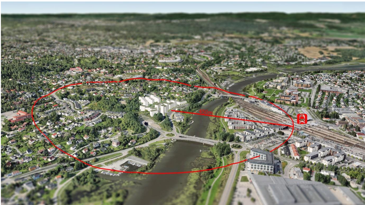
Oversikt over planområdets plassering i forhold til Lillestrøm stasjon, ill. Link Urban
