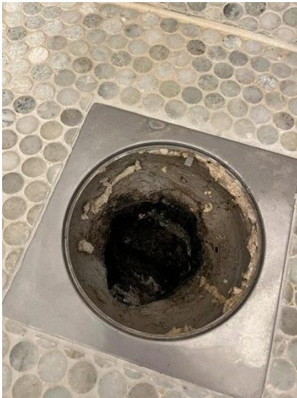
Våtrom - [Sluk på bad ]
