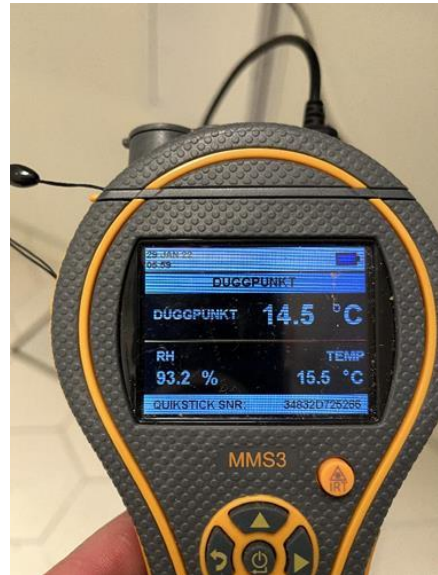
Rom under terreng (kjeller, underetasje, sokkeletasje) - [Fuktmåling i vegg under terreng ]
